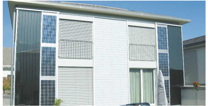
Solaranlage an Fassade
