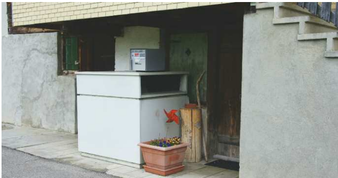
Baubewilligungspflichtige Luft/Luft-Wärmepumpe mit Luftbezug ausserhalb des Gebäudes
