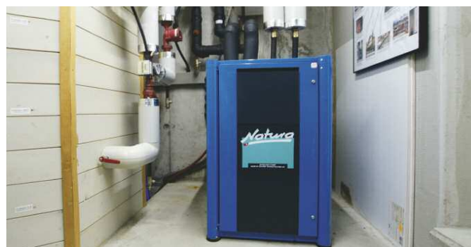
Baubewilligungsfreie Erdwärmesonden-Wärmepumpe
